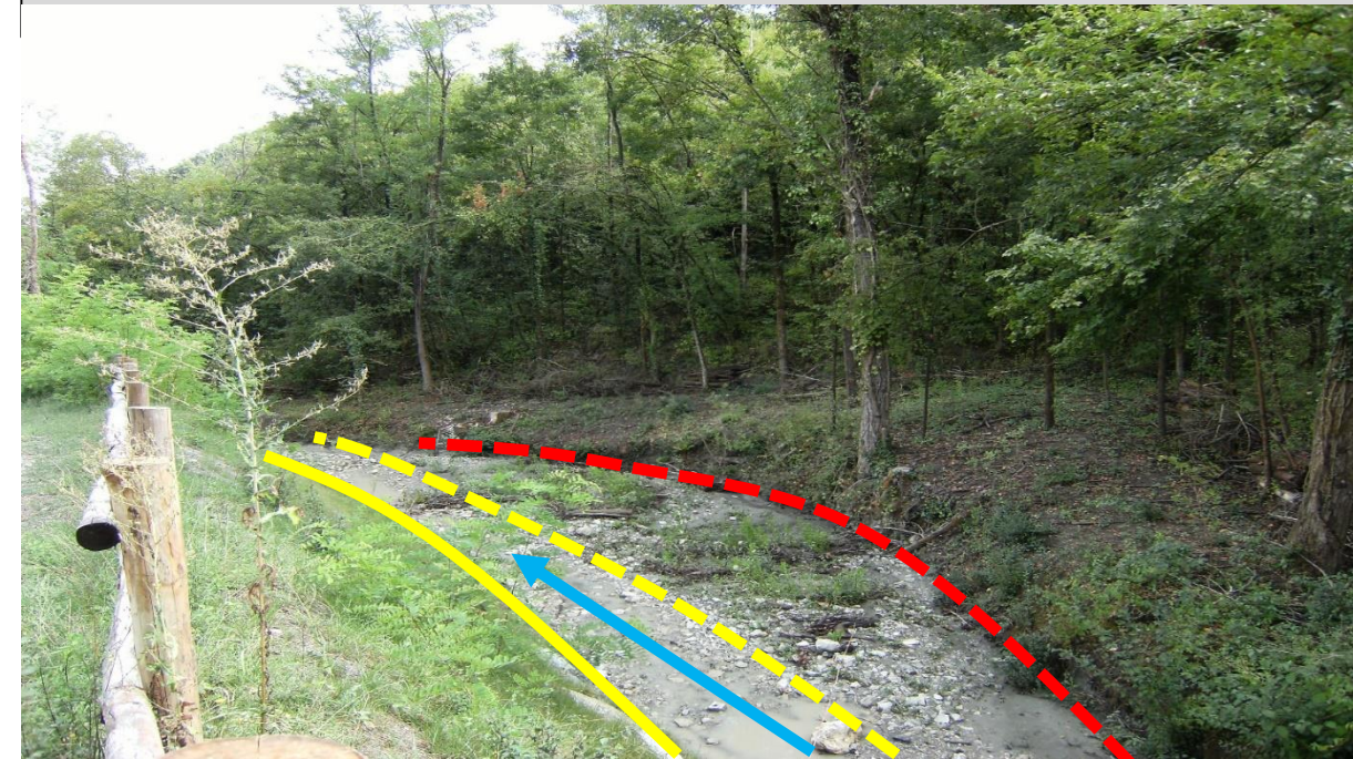
Sito di intervento durante il rilievo del 18/08/2015. In giallo continuo la sponda sinistra, in giallo tratteggiato la sponda destra pre intervento, in rosso la sponda destra arretrata
