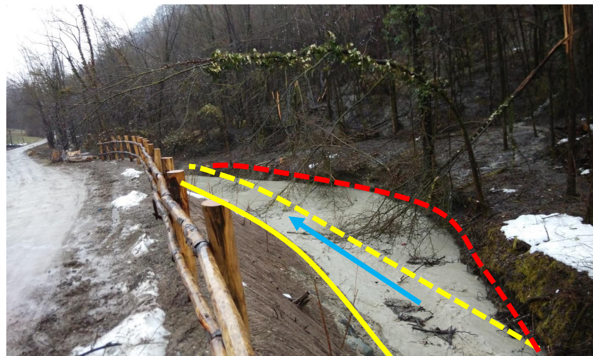
Sito di intervento durante il rilievo del 22/02/2015. In giallo continuo la sponda sinistra, in giallo tratteggiato la sponda destra pre intervento, in rosso la sponda destra arretrata
